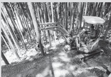
後ろ側も転圧しないとバックホウを倒します
