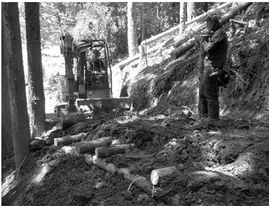
奈良型作業道の路面処理(丸太組み埋設) 施工中の協力隊員(奥から谷内、金原)
