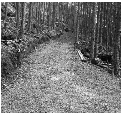
改良工事後の奈良型作業道 （滝の谷本線）
