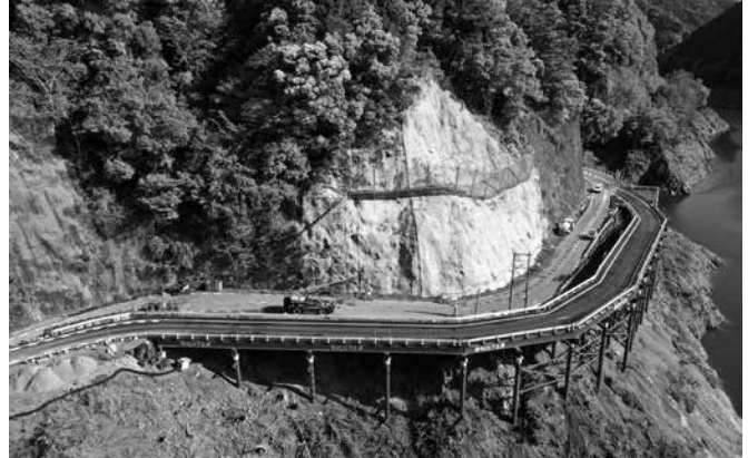
上空からの仮橋の様子
